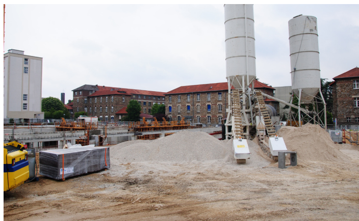
Photo du chantier, le 14 mai 2010
